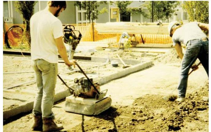
Fig. 1.2 La compaction est indispensable pour atteindre la capacité portante pour les trottoirs.
