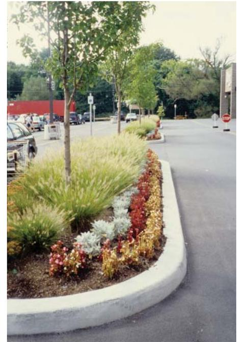
Fig. 1.14 Utilisation potentielle du CU-Sol Structural<sup>MD</sup> pour agrandir l'îlot de plantation dans un stationnement sans sacrifier l'espace pour les voitures.
