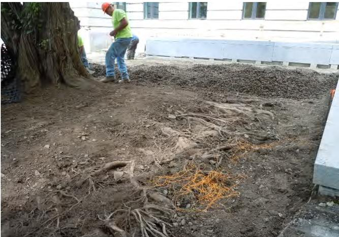
*Le sol autour des racines est excavé avec un dispositif d'excavation à air.*
