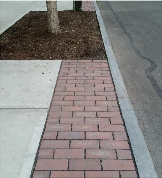
*pavés permet à l'eau de s'infiltrer dans le CU-Sol<sup>MD</sup> dessous.*
