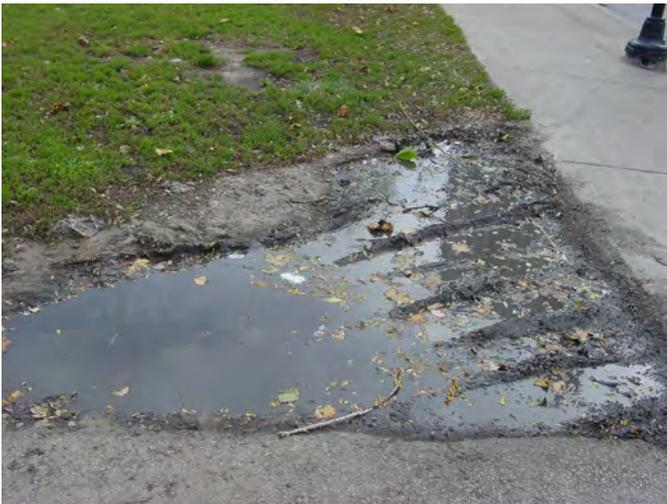
*Cette section gazonnée a été détruite par l'usure de la circulation véhiculaire qui a compacté le sol et limité sa capacité de drainage. Le résultat : une pelouse « noyée ».*
