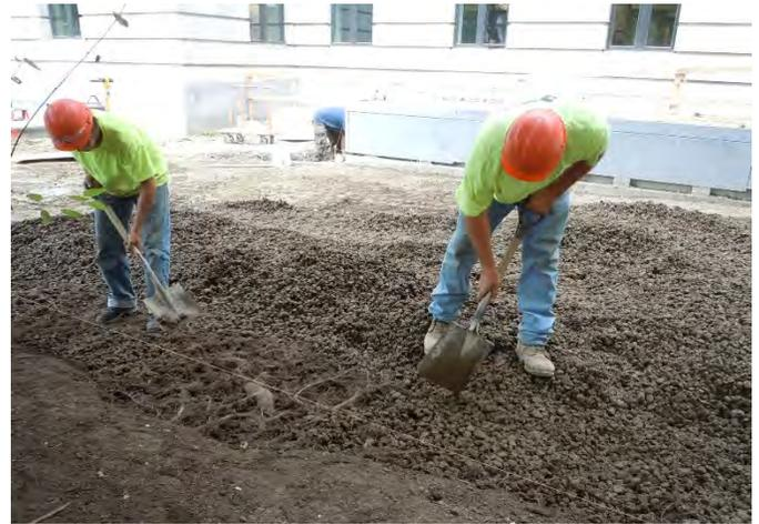
*Une couche de 12 à 15 po de CU-Sol<sup>MD</sup> est déposée sur les racines exposées et ensuite compactée pour former la couche de base du nouveau revêtement.*
