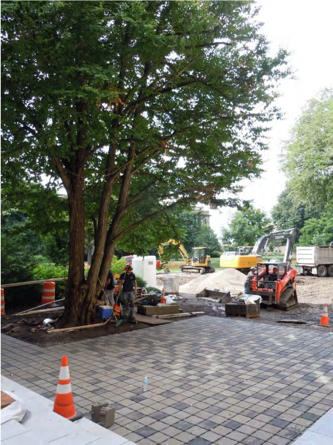
*Les racines de cet arbre de Katsura étaient menacées par la construction d'un nouveau mail. L'arbre fut préservé grâce à une planification soigneuse et l'utilisation du CU-Sol Structural<sup>MD</sup> autour des racines existantes. Le revêtement fut installé sur le CU-Sol<sup>MD</sup>.*
