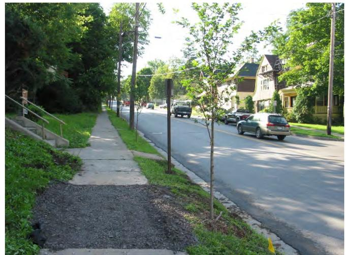
*Ithaca, NY — Puisque cette plantation d'arbres gazonnée est très étroite, une section du trottoir a été retirée et sera remplacée avec une fondation en CU-Sol<sup>MD</sup>.*
