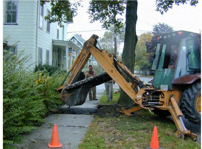
*Ithaca, NY — Retirer et ensuite remplacer cette section de trottoir avec une fondation de CU-Sol Structural<sup>MD</sup> permettra aux racines de se développer librement.*
