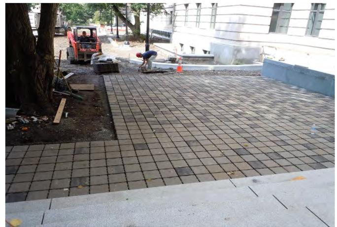
*Un revêtement perméable est installé par-dessus le CU-Sol<sup>MD</sup> et le système racinaire existant.*
