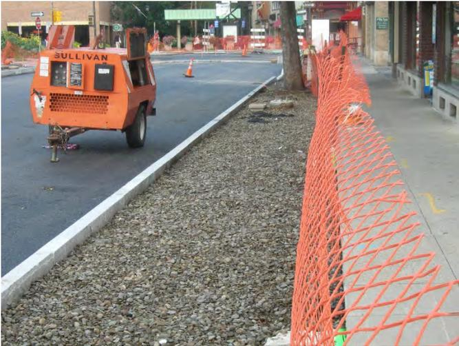
*Ithaca, NY — Le réaménagement de la rue et du trottoir présente une occasion idéale pour utiliser le CU-Sol Structural<sup>MD</sup> comme couche de base de 36 po pour remplacer une section du trottoir. Cette méthode permet aux racines des arbres existants de sortir de l'espace restreint.*
