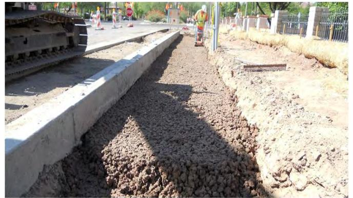
*Compaction du CU-Sol Structural<sup>MD</sup> durant l'installation. Pour assurer une installation adéquate, il doit être compacté chaque 6 pouces. Photo : AZ Best, LLC*
