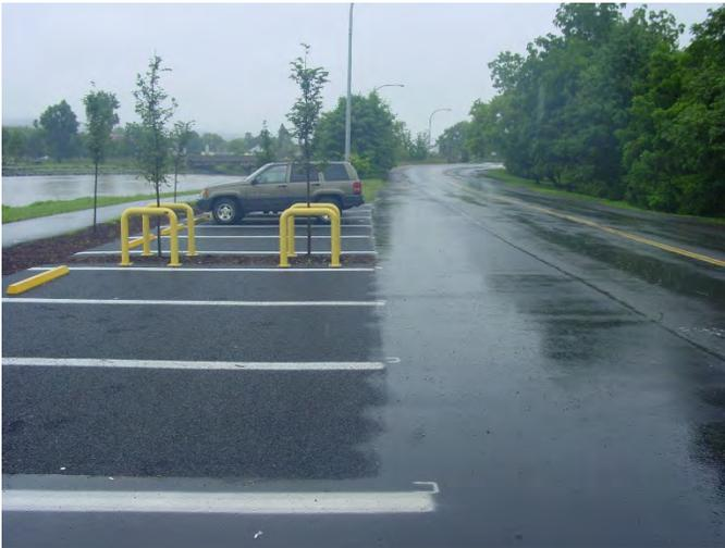
*Ithaca, NY — Une installation avec de l'asphalte poreux et du CU-Sol<sup>MD</sup> peu de temps après la construction.*
