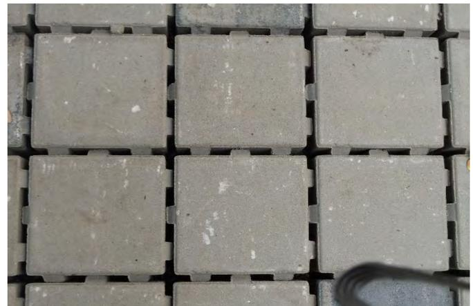
*Les espaces vides permettent à l'eau et l'air de s'infiltrer dans le sol.*
